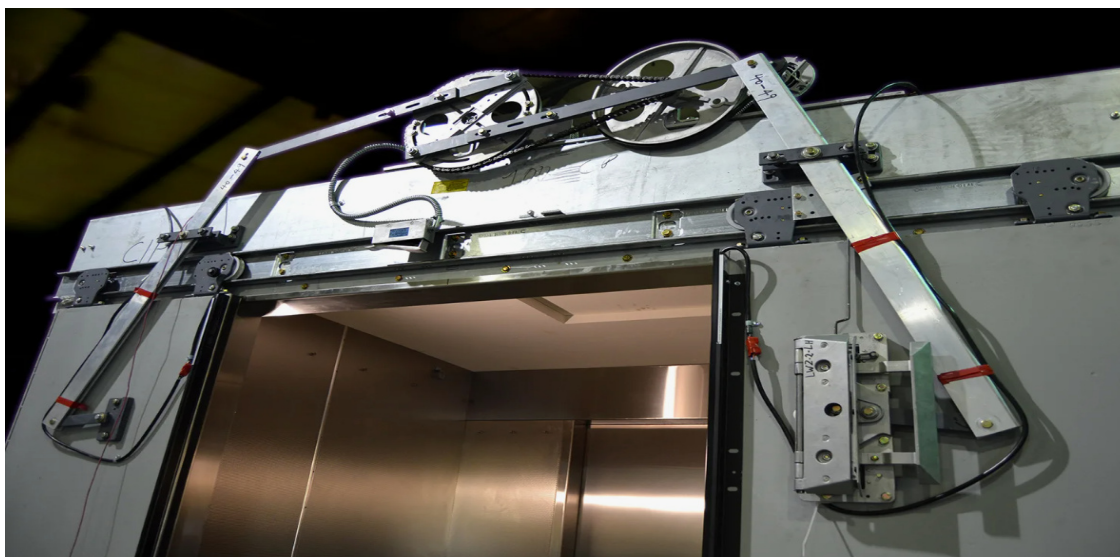
Рисунок 3 – Лифтовое оборудование с винтовым механизмом
